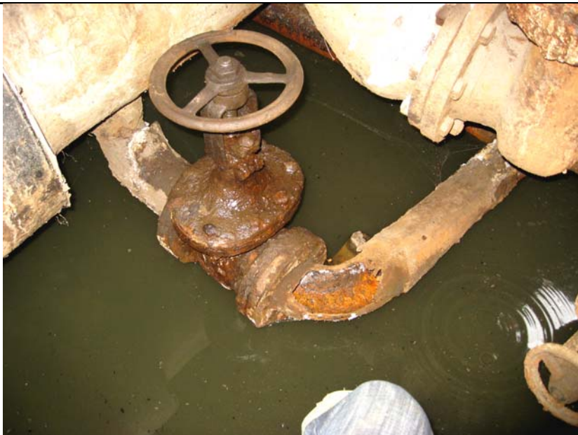
Рис. 4. Тепловая камера (затопленная)
